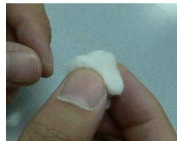
ทำความสะอาดสายใยแก้วเปลือย
